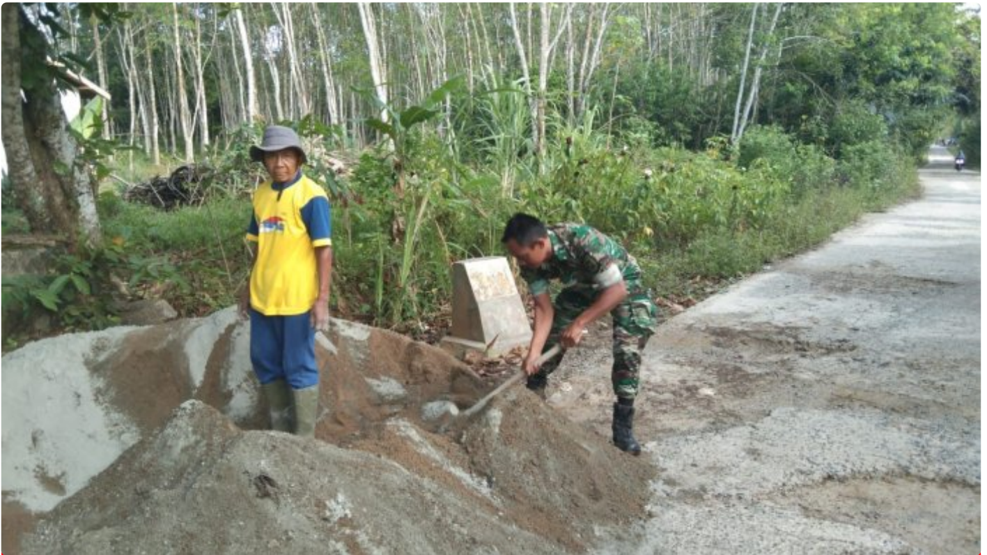
Babinsa Bantu Gotong Royong Pengecoran Jalan
